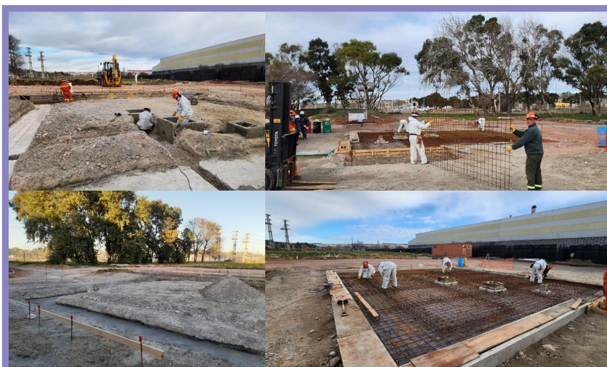
Figura 8: Avances de la obra hasta Jun23.
