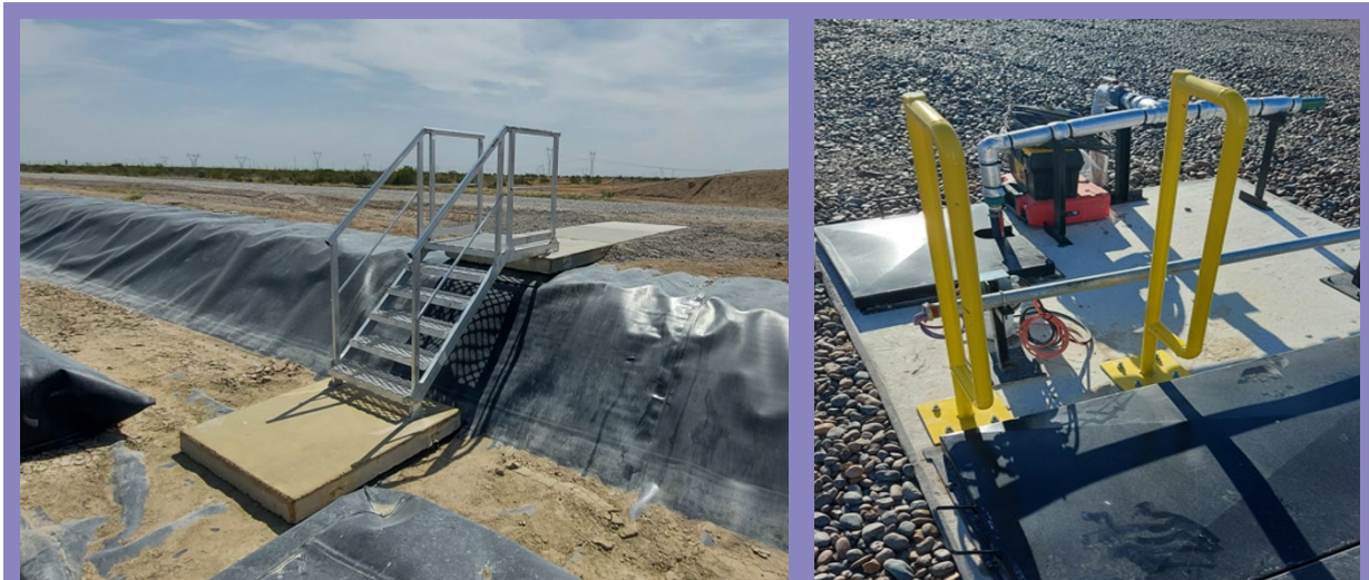
Figura 4: Escalera para el acceso a la Pileta de Lixiviados y acceso a planta de efluentes cloacales.
