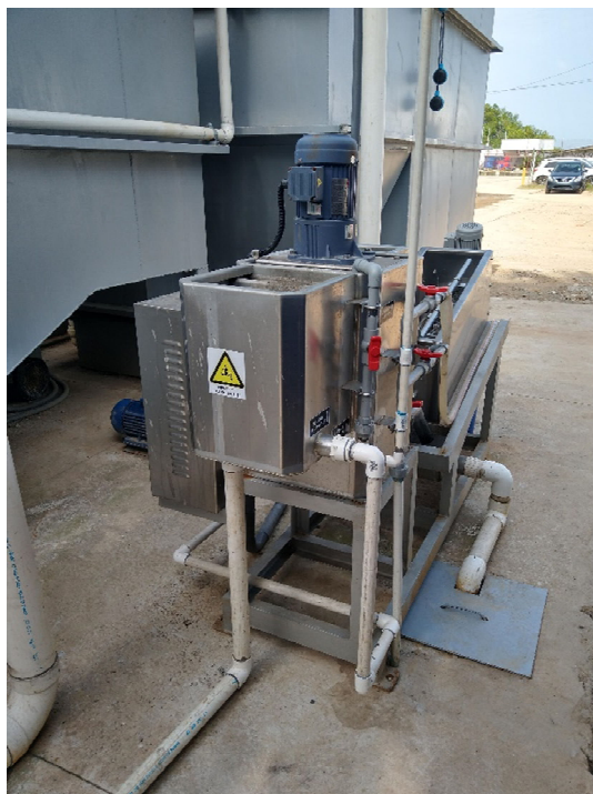
Figura N° 16: Ejemplo de tratamiento de barros por filtro prensa a tornillo.
